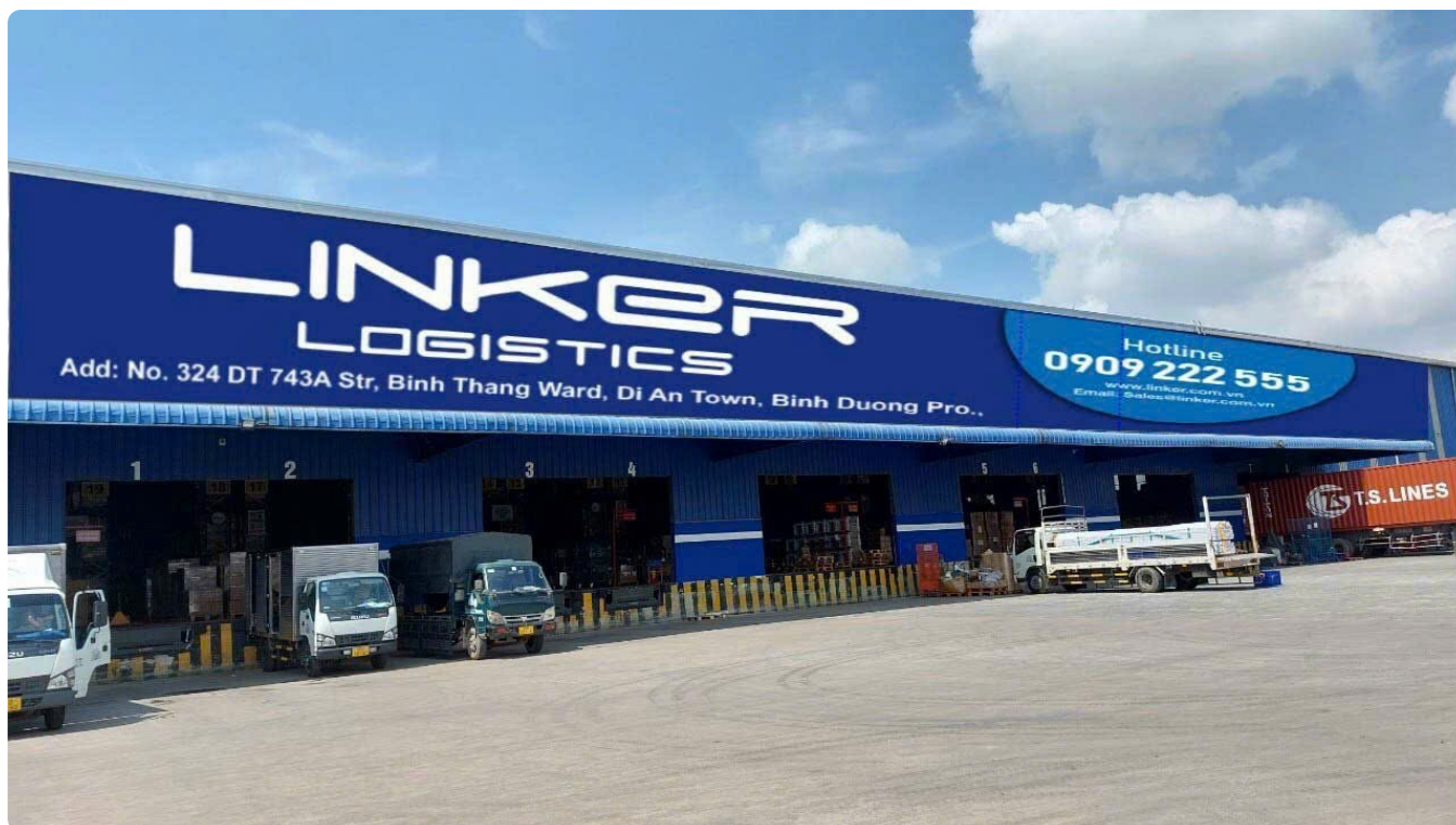
Hệ thống cửa xuất nhập hàng (loading docks) vận hành liên tục tại kho Linker Logistics.
